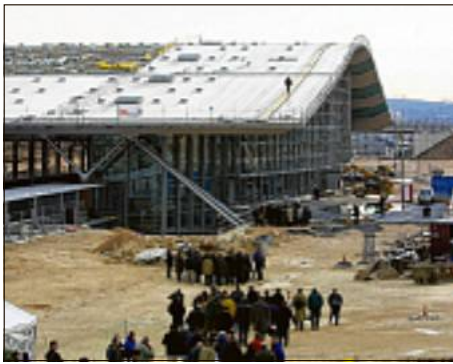
La gare en chantier en janvier 2001, soit six mois avant l'inauguration de la nouvelle ligne à grande vitesse Paris-Marseille
